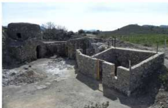
RESTAURACIÓN DEL CONJUNTO DE HORNOS DE YESO EN EL CERRO DEL CUARTE EN SAX
