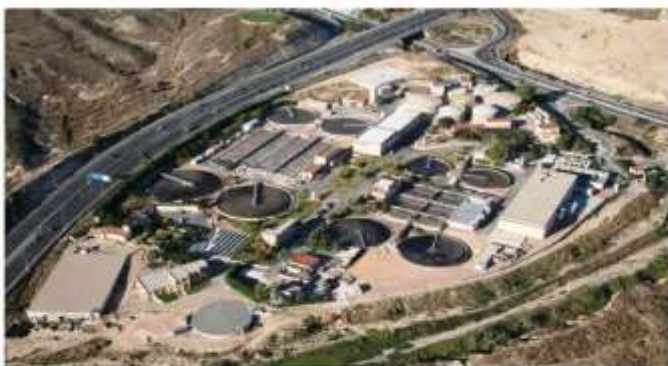
DEPURADORA DE ALICANTE (PENCÓN DE LEBON)
